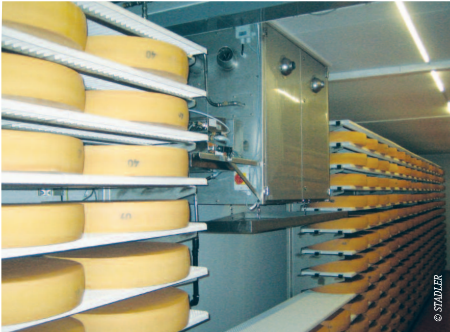
ESJET® HX mit integrierter Befeuchtung in einem Sanierungsobjekt unter beengten Verhältnissen
