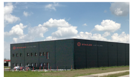
Neue Produktionshalle in Salgen / Allgäu
